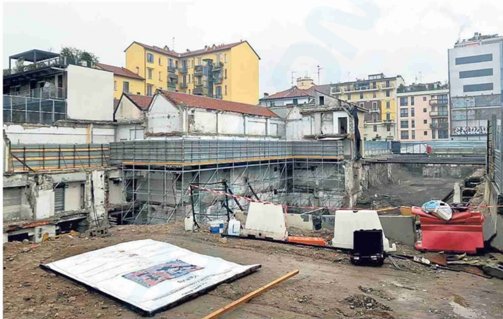
▲ Il cantiere tra via Crema e piazzale Trento MAURIZIO MAULE FOTOGRAMMA
